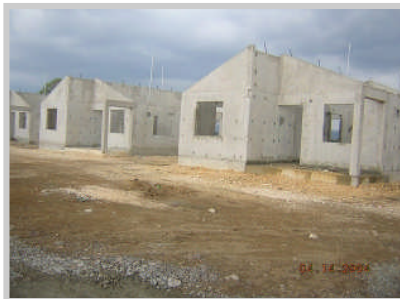
ขั้นที่ 2 ถอดแบบ ไม่ต้องฉาบปูนอีก
