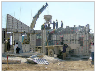
ขั้นที่ 1 ติดตั้งแบบสำเร็จรูป แล้วเทด้วย
