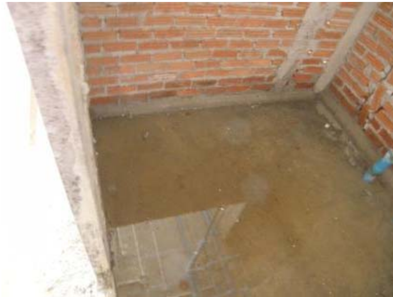
ภาพประกอบที่ ก.9 แสดงการขังน้ำเพื่อทดสอบการรั่วซึมภายในห้องน้ำ
