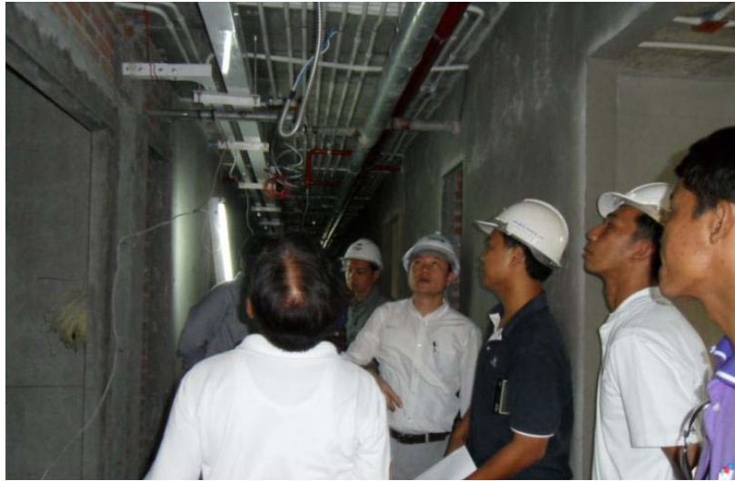
ภาพประกอบที่ ก.11 แสดงทีมผู้บริหาร ผู้ควบคุมงาน ทีมงานผู้ออกแบบ และทีมงานผู้รับเหมา ก่อสร้าง เข้าตรวจการทำงาน
