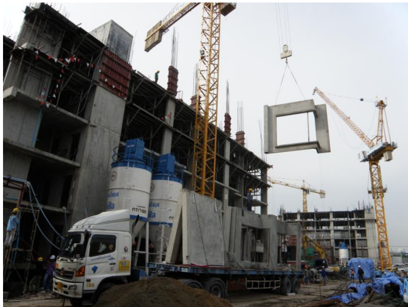
ภาพประกอบที่ ก.4 แสดงการการขนส่งและติดตั้งแผ่นผนังคอนกรีตสำเร็จรูป
