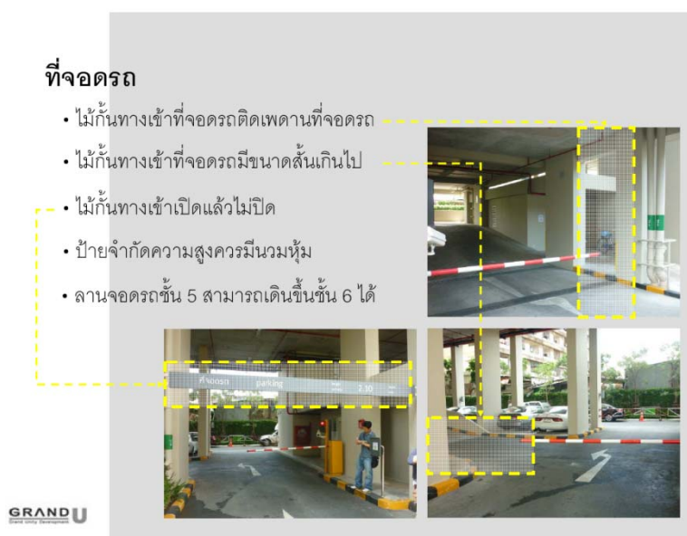
ภาพประกอบที่ ก.18 การตรวจสอบงานก่อสร้างจากทีมงานตรวจสอบงาน หลังการก่อสร้างบริเวณลานจอดรถ
