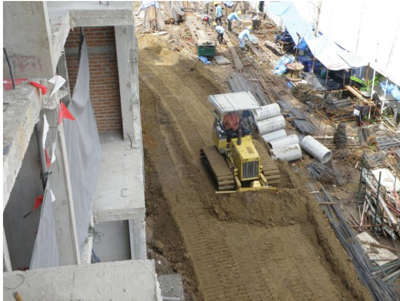
ภาพประกอบที่ ก.5 แสดงการบดอัดดินเพื่อทำถนนรอบโครงการ เพื่ออำนวยความสะดวกในการขนส่ง
