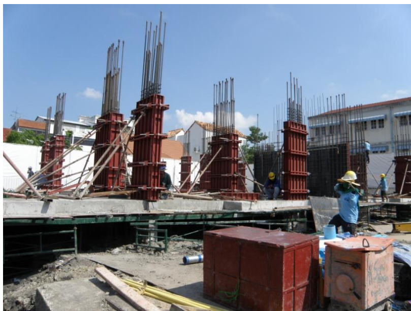
ภาพประกอบที่ ก.2 แสดงการติดตั้งแบบเหล็กเสาสำเร็จรูป
