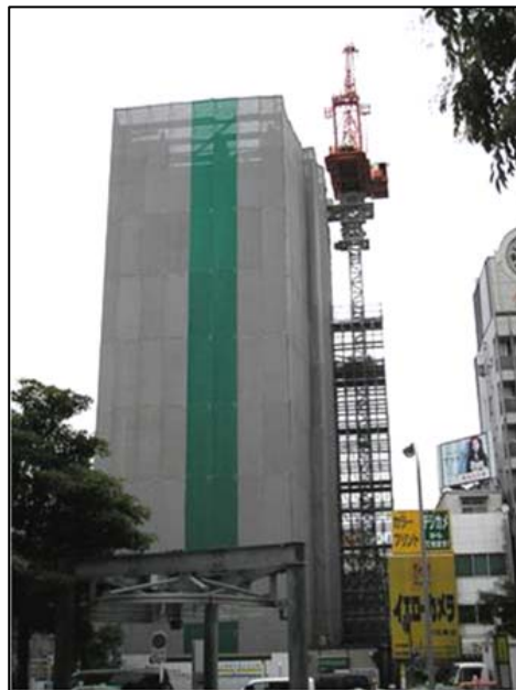
ภาพประกอบที่ 4.8 มีการจัดทำแผงผ้าใบกันฝุ่นรอบอาคาร
