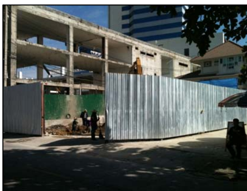
ภาพประกอบที่ 4.2 รั้วที่บดโดยรอบแนวเขตที่ดินด้วยแผ่นเหล็กเคลือบรีดลอน (Metal Sheet)
