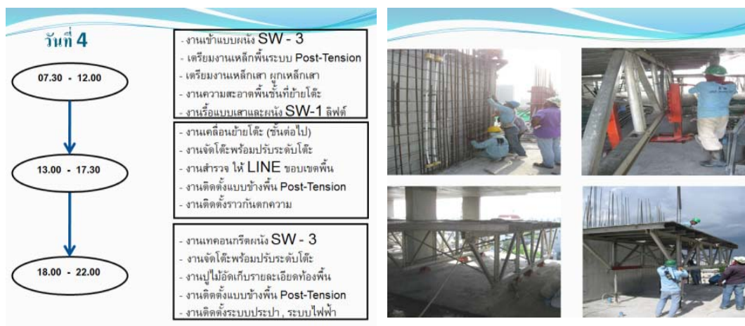
ภาพประกอบที่ 4.57 แสดงรายการงานที่ดำเนินการวันที่ 4
