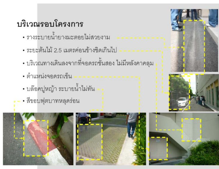
ภาพประกอบที่ ก.17 การตรวจสอบงานก่อสร้างจากทีมงานตรวจสอบงาน หลังการก่อสร้างบริเวณรอบโครงการ
