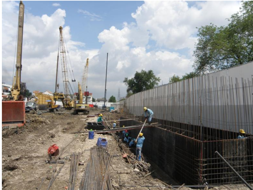
ภาพประกอบที่ ก.1 แสดงการทำงานก่อสร้างภายในโครงการของบริษัทแกรนด์ ยูนิตี้ ดีเวลลอปเม้นท์ จำกัด
