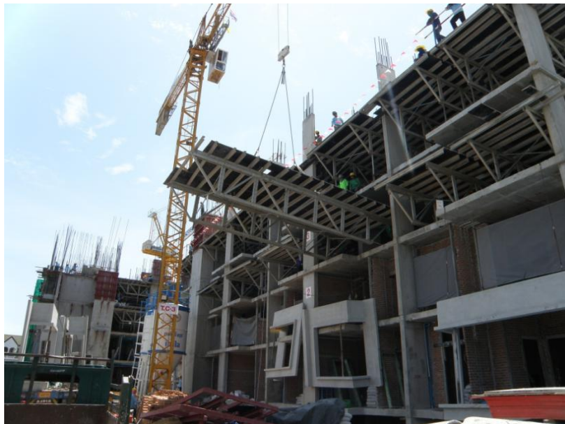
ภาพประกอบที่ ก.6 แสดงขนย้ายไม้แบบพื้นสำเร็จรูป เพื่อนำไปติดตั้งที่ชั้นต่อไป
