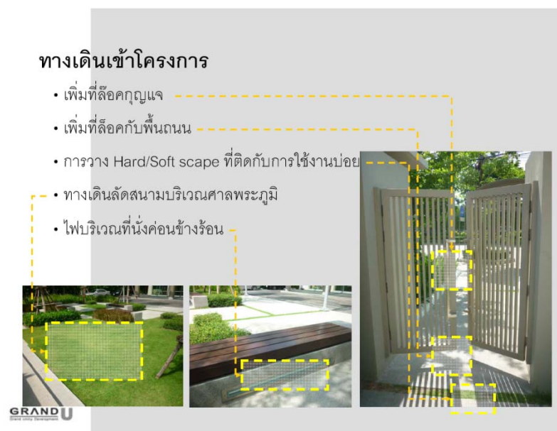
ภาพประกอบที่ ก.14 การตรวจสอบงานก่อสร้างจากทีมงานตรวจสอบงาน หลังการก่อสร้างบริเวณ ทางเดินเข้าโครงการ
