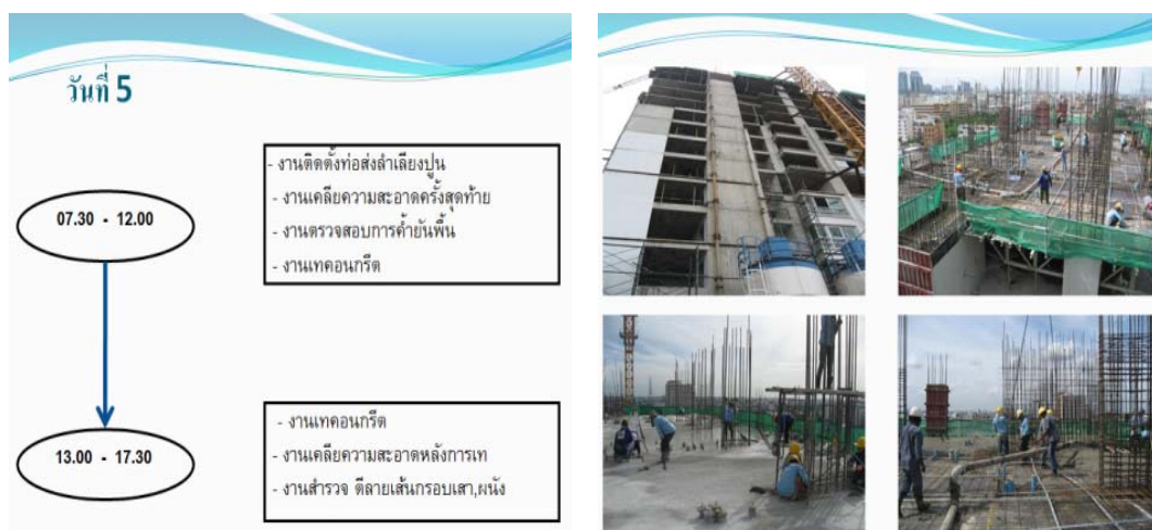
ภาพประกอบที่ 4.58 แสดงรายการงานที่ดำเนินการวันที่ 5
