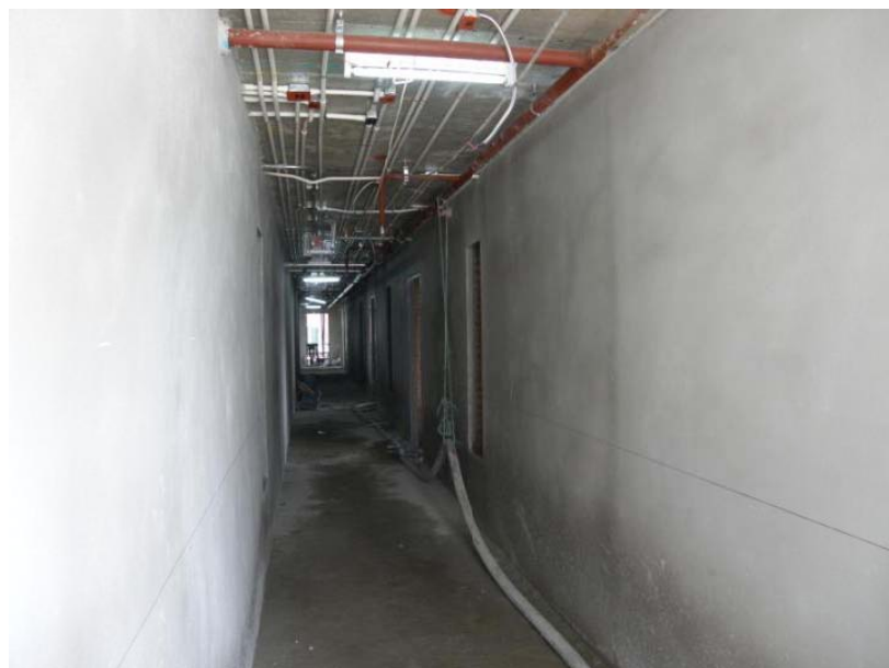
ภาพประกอบที่ ก.10 แสดงงานฉาบปูนผนังภายในอาคาร
