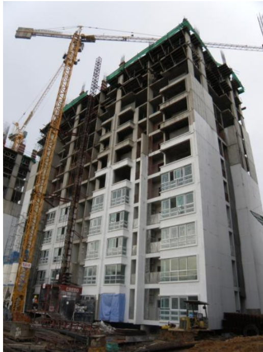
ภาพประกอบที่ ก.7 แสดงงานติดตั้งเฟรมอลูมิเนียมหน้าต่าง
