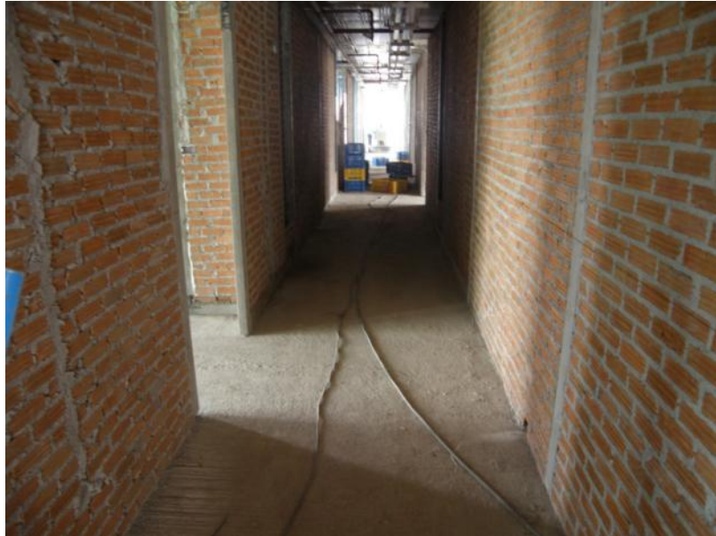
ภาพประกอบที่ ก.8 แสดงงานก่ออิฐภายในอาคาร
