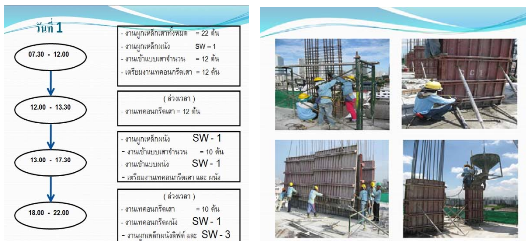
ภาพประกอบที่ 4.54 แสดงรายการงานที่ดำเนินการวันที่ 1
