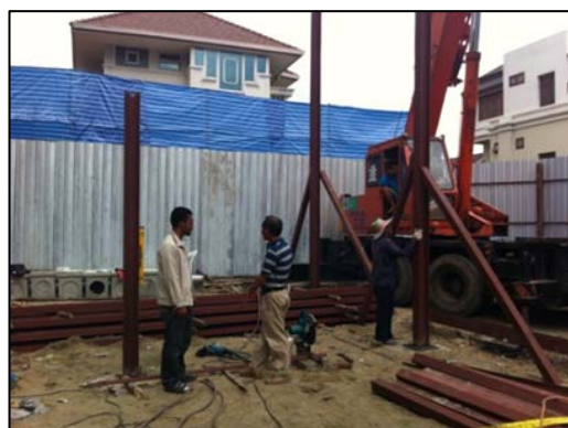
ภาพประกอบที่ 4.2 รั้วที่บดโดยรอบแนวเขตที่ดินด้วยแผ่นเหล็กเคลือบรีดลอน (Metal Sheet)
