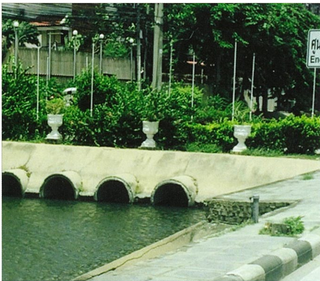
รูปที่ 3 ลักษณะท่อคอนกรีตระบายน้ำที่ใช้กันอยู่ทั่วไปในปัจจุบันในประเทศไทย เพราะมีราคาวัสดุถูกและก่อสร้างง่ายกว่าการสร้าง Box Culvert
